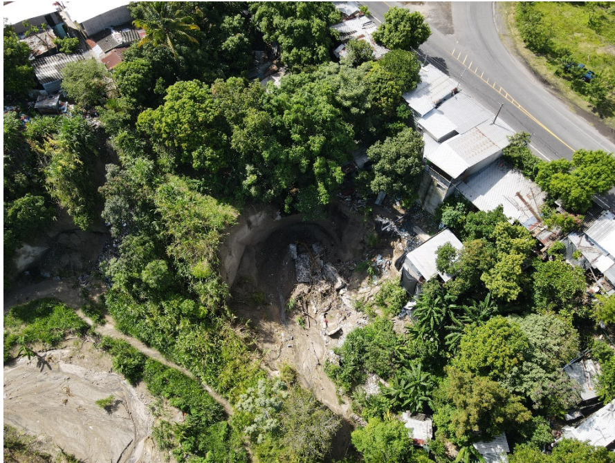
Imagen 2. Cárcava formada por la descarga de la carretera
