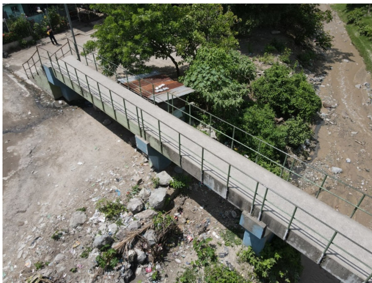
Imagen 1. Puente peatonal ubicado en lotificación San José Changgallo
