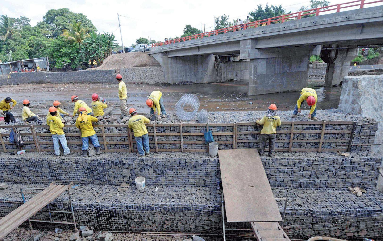
Obras de protección para encausamiento de río en construcción del puente Copapayo, carretera a Sonsonate.
