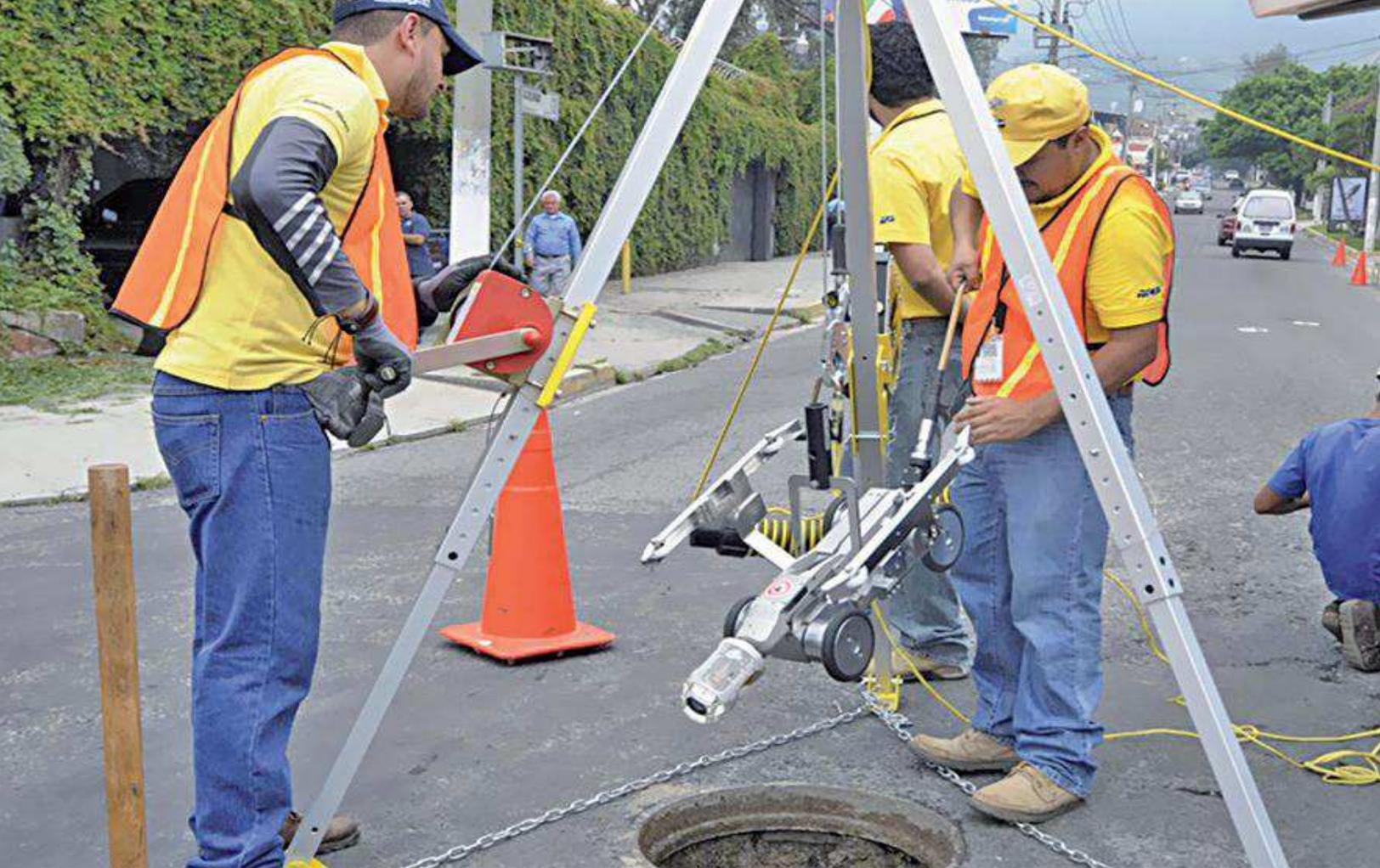
El robot-cámara (CCTV) forma parte del equipo tecnológico que el MOP usa para la gestión integral de sistemas de drenaje de aguas lluvias.
