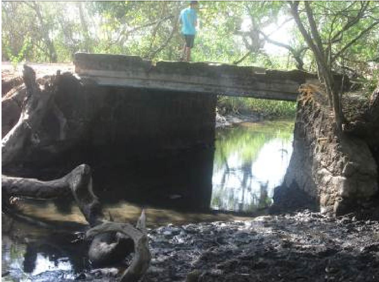
Puente existente de 6.50 metros de longitud, a sustituir.
