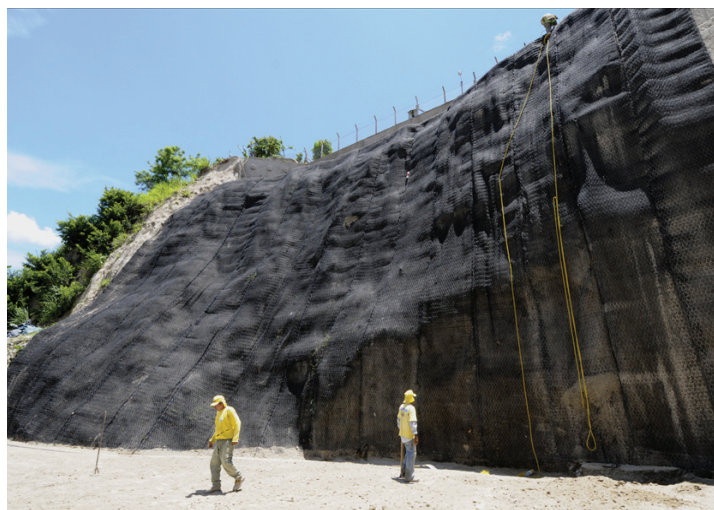
Obras de mitigación en San Bartolo, Ilopango.
