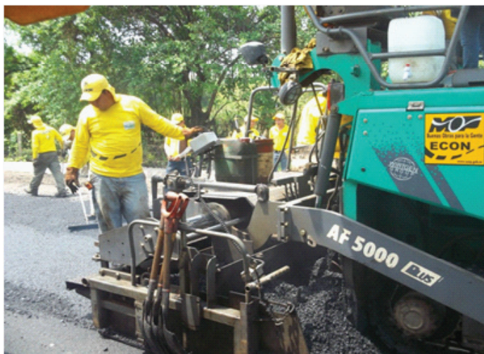
Construcción del By Pass en Usulután.
