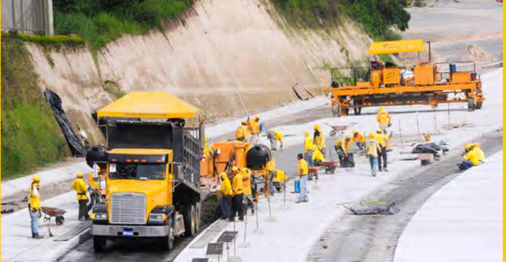
*El Tramo II de Diego de Holguín, tiene 3.9 kilómetros de longitud, se ha subdividido en Tramo II-A y Tramo II-B, ambos se construyeron con base de concreto hidráulico. Posee para la circulación vehicular seis carriles de 3.65 metros de ancho cada uno, tres por sentido, hombros externos de 2.50 metros e internos de un metro y un separador central.*
