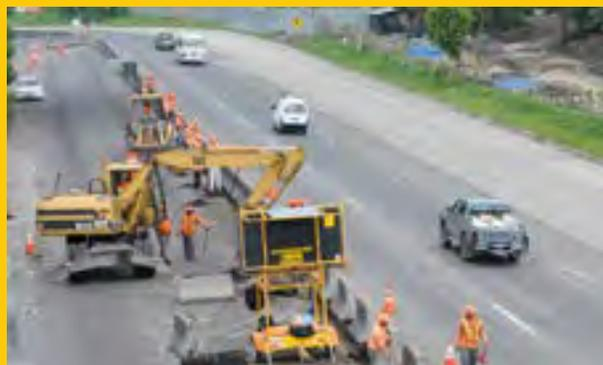
**Es así como el 17 de septiembre se iniciaron las obras masivas para la construcción de la Nueva Autopista Los Chorros; este proyecto de gran envergadura que comprende actividades de remoción de carpeta existente, estabilización de base, colocación de carpeta de rodaje, construcción de canaletas y subdrenajes y señalización vial.**
