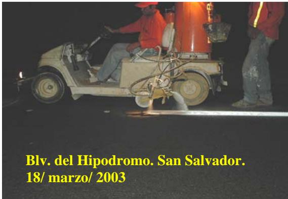
B.1) Máquina Franjeadora Autopropulsada para la aplicación de pinturas convencionales de tráfico. (Método de Esprayado).
