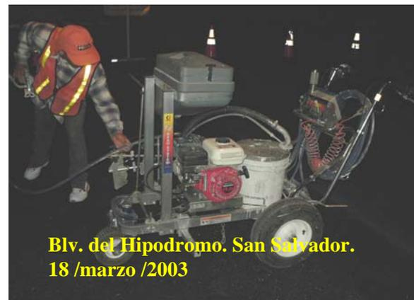
D) Equipo Manuales para la aplicación de pinturas Caucho Clorado. (Método Esprayado)
