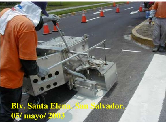
C) Equipo Manuales para la aplicación de pinturas Termoplásticas. (Método Extrusión)
