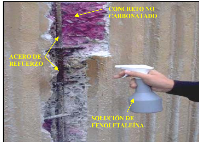
Fotografía 2: Aplicación de solución de fenolftaleína en superficie recién expuesta de concreto.
