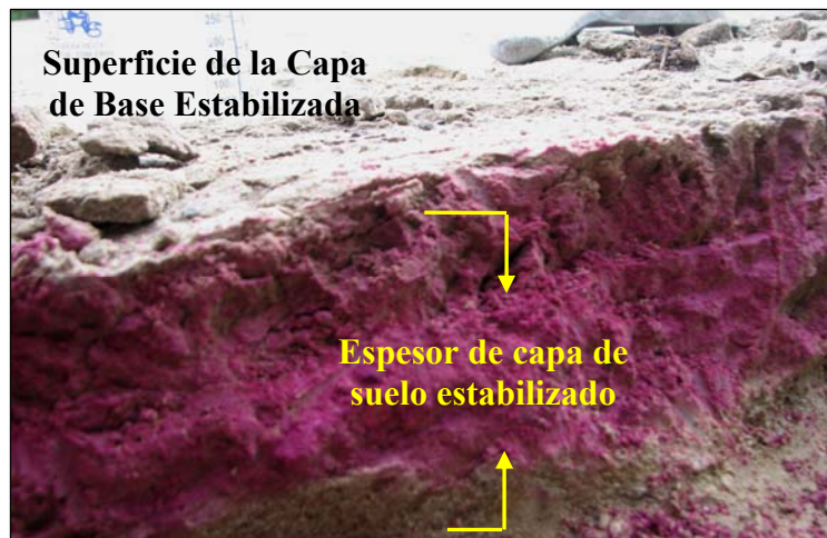
Fotografía 5: Vista de capa de base suelo-cemento con aplicación de fenolftaleína. [Registro fotográfico de trabajos de verificación de la calidad, durante la construcción de estructura de pavimento, UIDV-VMOP - Ministerio de Obras Públicas de El Salvador]
