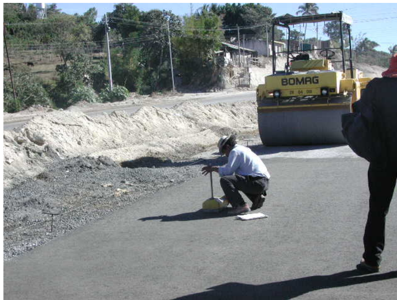
Fotografía 5. Proyecto: Paquete II. Compactación final con rodo liso y determinación de la densidad de campo de la capa de CCR, utilizando un densímetro nuclear.
