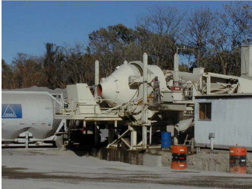
Fotografía 3. Proyecto: Paquete II. Planta dosificadora utilizada para la producción de la mezcla para CCR.
