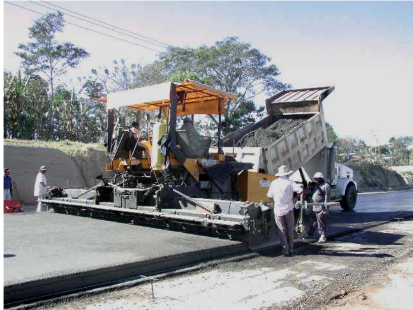
Fotografía 4. Proyecto: Paquete II. Colocación y compactación inicial de la mezcla para CCR , utilizando la máquina pavimentadora.
