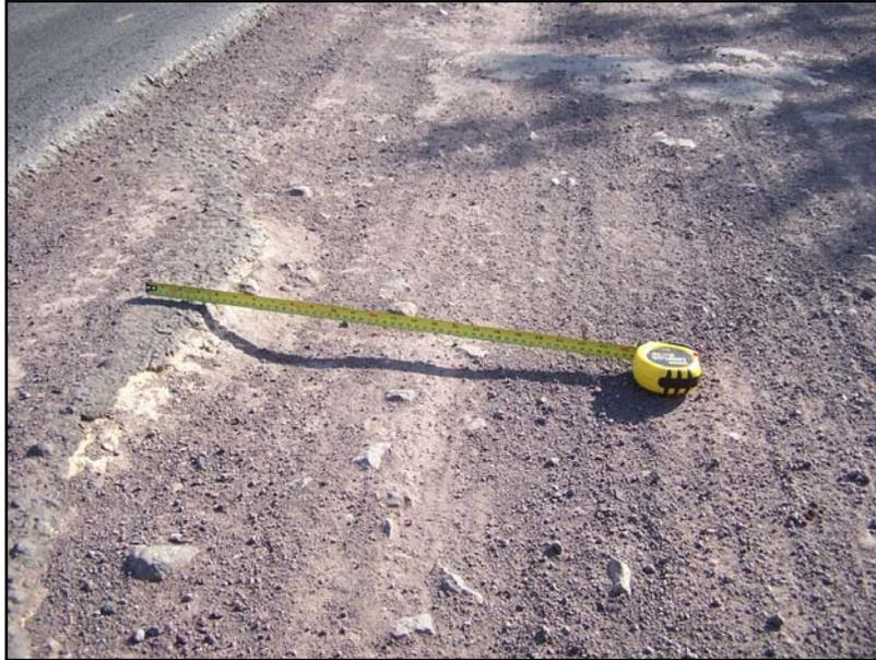
**Fotografía 2.** Capa sobre la que se apoyará la capa de rodadura, con irregularidades importantes.
