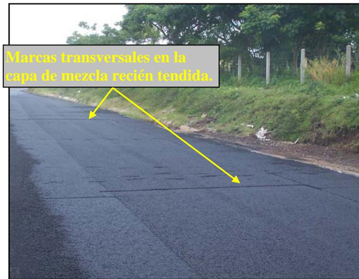
**Fotografía 3.** Marcas transversales formadas en la capa de mezcla recién tendida, originadas por la enrasadora cuando realiza un deficiente proceso de descarga de la mezcla.
