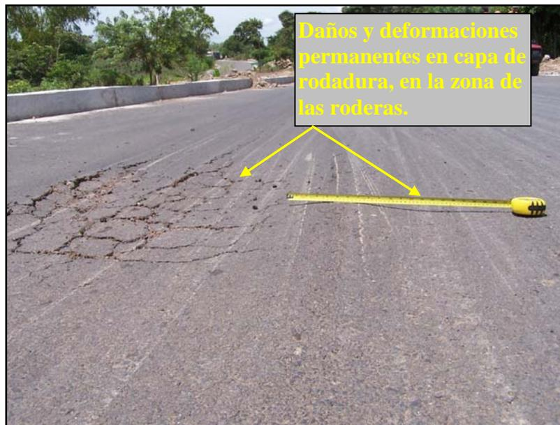
**Fotografía 1.** Deformaciones y agrietamientos en la capa de rodadura, originados por la presencia de materiales con características plásticas en las capas subyacentes.
