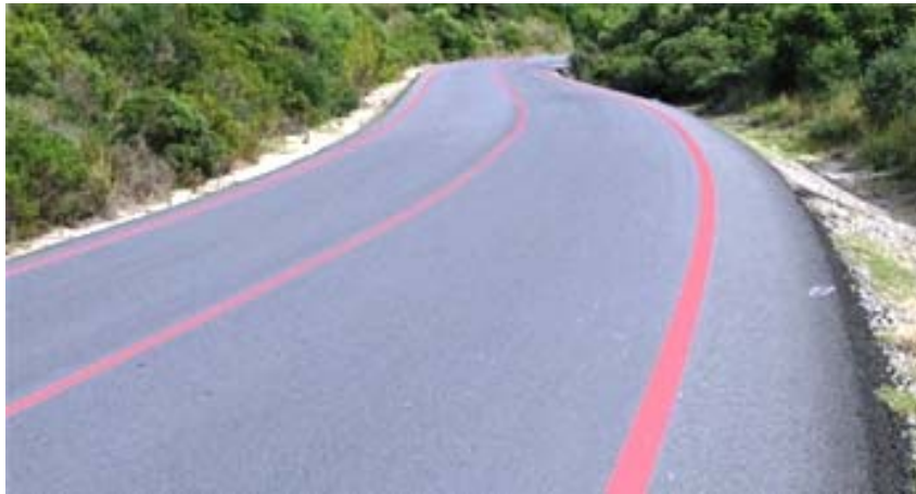
Fotografía 10. Pintura termocromática sobre estructura de pavimento.
