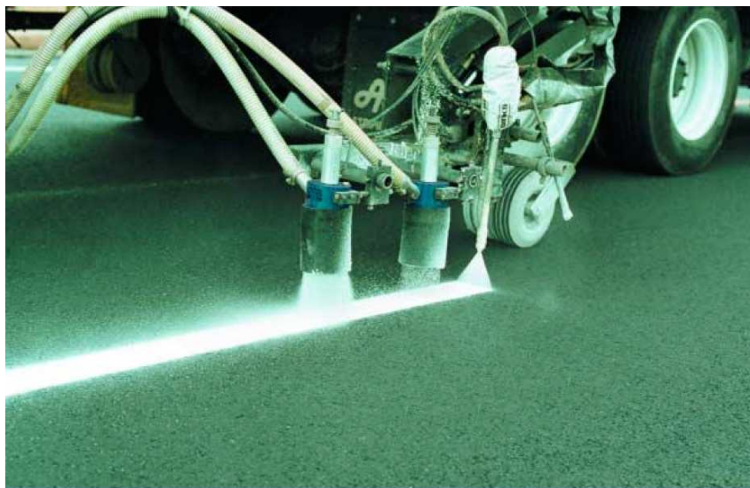
Fotografía 8. Equipo para la colocación de pintura, implementando el método de doble aspersión de esferas de vidrio [Tomado de www.pottersindustriesinc.com ]
