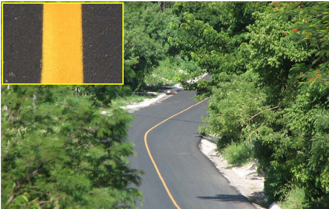
Fotografía 9. Demarcación horizontal a base de pintura Acrílica de Base Agua.
