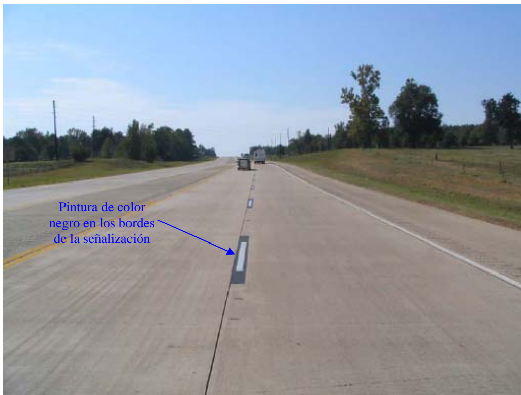
Fotografía 4. Incremento del fenómeno del Contraste mediante la aplicación de pintura de color negro en los bordes de la señalización [Tomado de Evaluation of wet-weather and contrast de la FHWA, pág 67]
