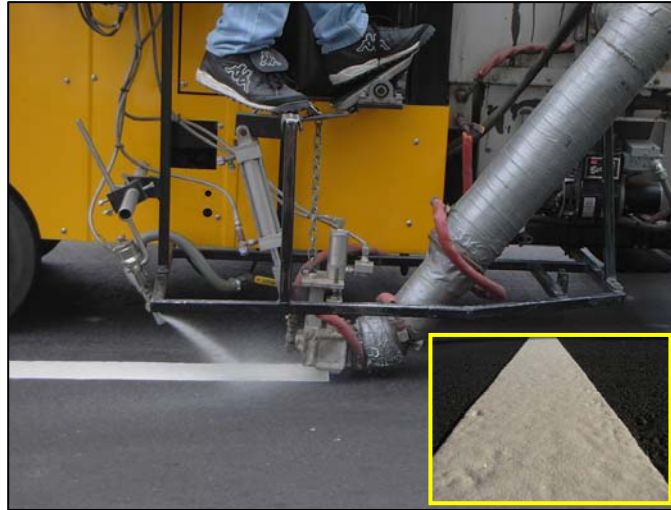
Fotografía 7. Equipo para la colocación de pintura termoplástica por el método de extrusión. En recuadro se observa el acabado de la superficie de la señalización [Ministerio de Obras Públicas de El Salvador, Boulevard Santa Elena y By Pass Usulután]
