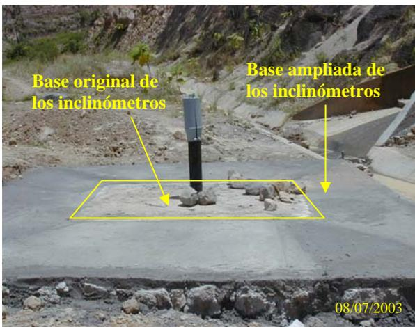
Fotografía 5.3. Ampliación de la base de los pozos inclinométricos, segunda berma del talud 3.
