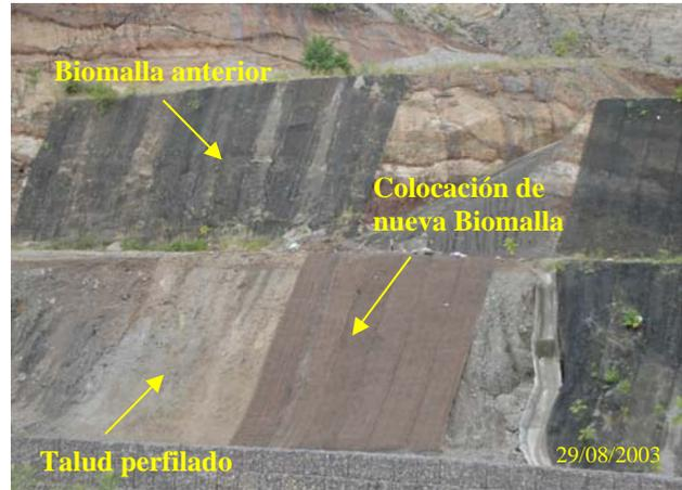
Fotografía 5.1b. **Solución Implementada.** Colocación de nueva Biomalla en el Costado Poniente del talud 3.
