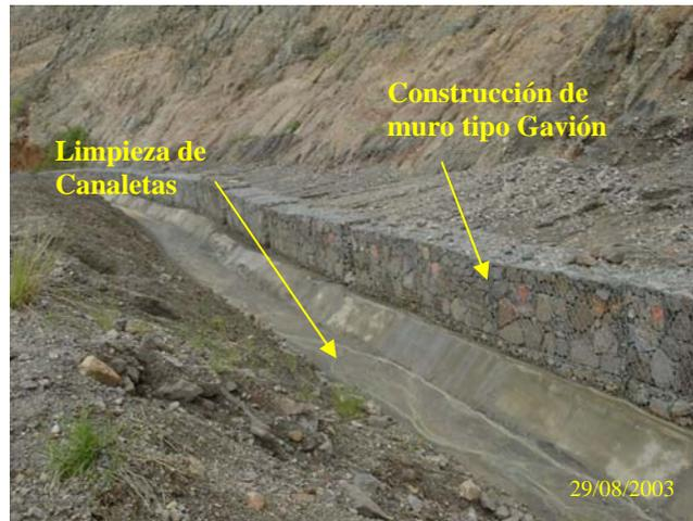
Fotografía 5.2b. **Solución implementada.** Construcción de muro tipo gavión contiguo a la canaleta ubicada en el Costado Poniente de la segunda berma del talud 3 y limpieza de la misma.
