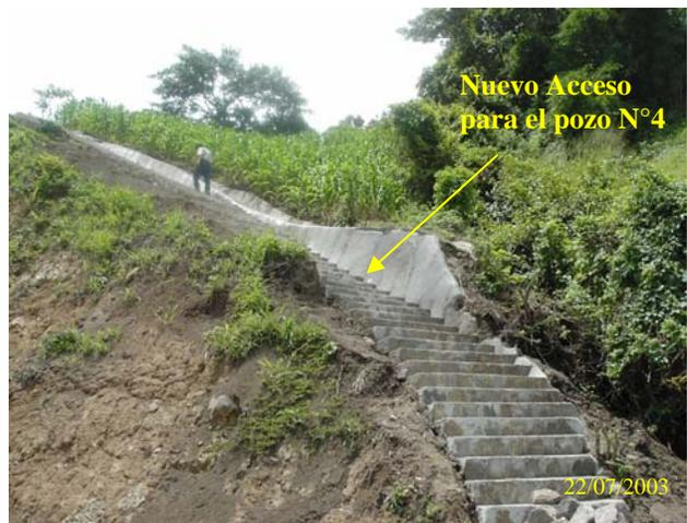
Fotografía 5.4. Construcción de un nuevo acceso para el pozo inclinométrico N°4.
