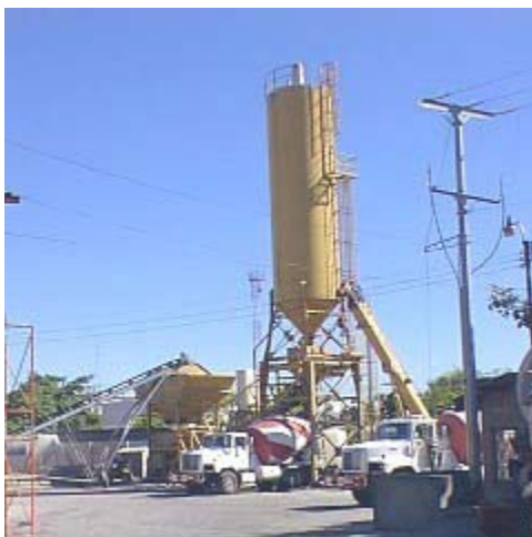
Foto 2. Planta de Concretera Salvadoreña. Silo de almacenamiento de cemento.
