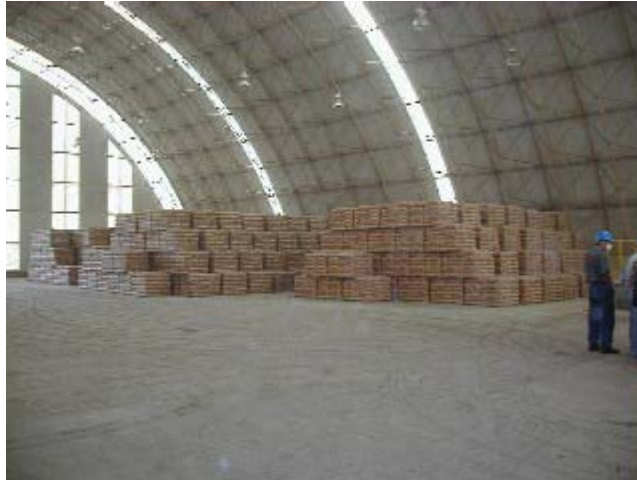
Foto 4. Planta El Ronco, CESSA. Bodega de almacenamiento para el cemento en bolsas.
